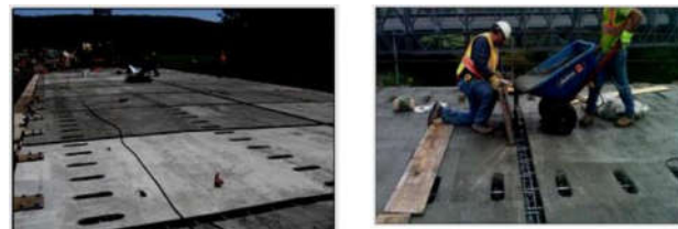
Hình 2. Thi công mặt cầu lắp ghép và mối nối mặt cầu bằng bê tông cường độ siêu cao tại công trường
